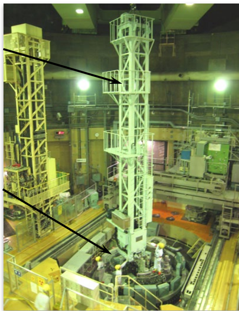
炉上部の様子 (燃料交換時の写真)
