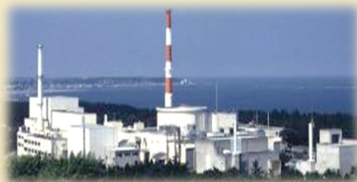
高速実験炉「常陽」
